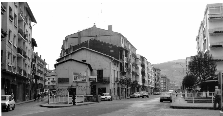
Paso subterráneo para peatones en la confluencia de Mayor con Arriba
